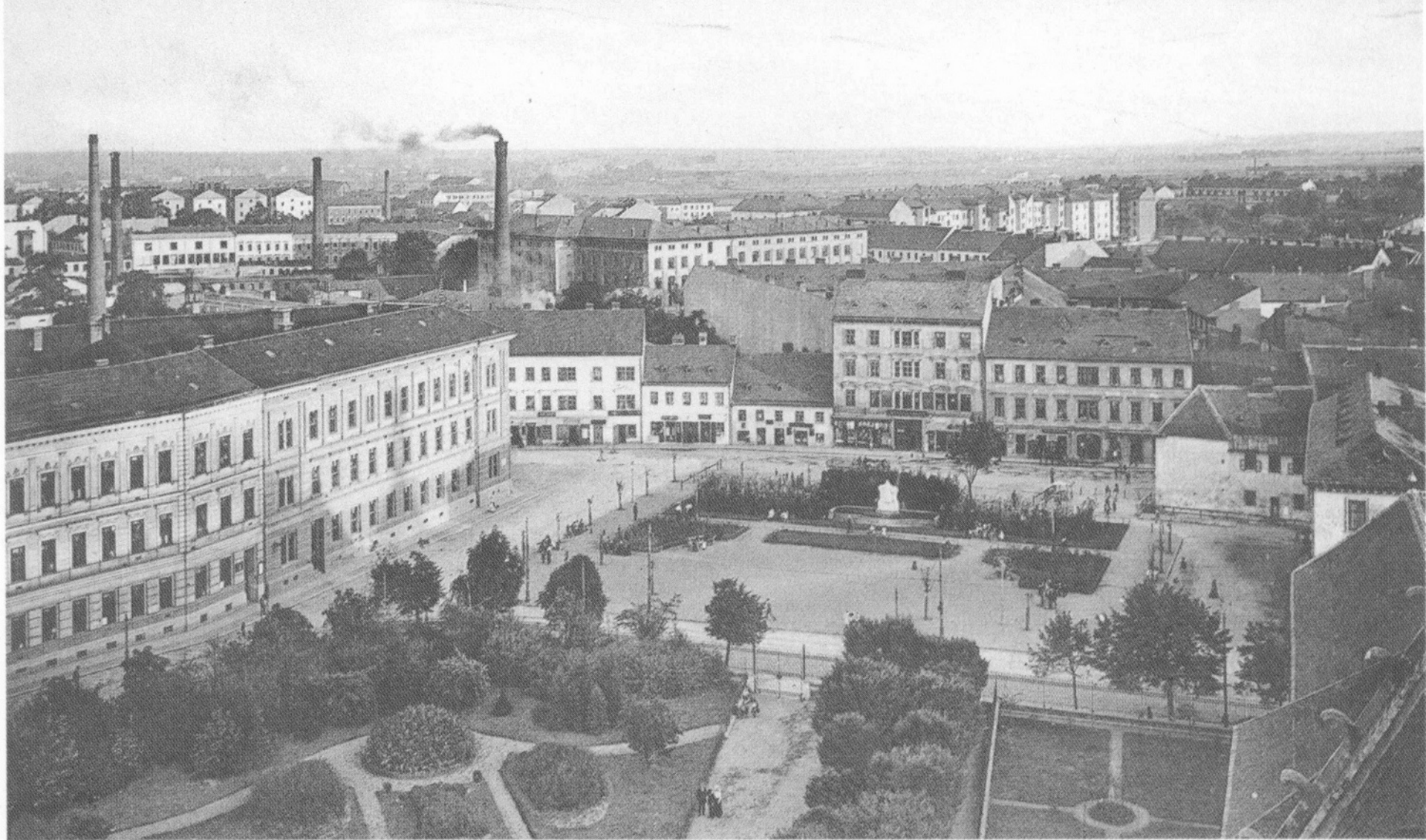
Brünn Altbrünn Mendelplatz mit II. Staatsrealschule u. Bürgerschule.
